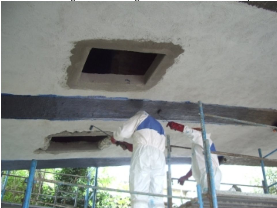
Fig. 1 - Rinforzo a flessione dell'intradosso delle travi
